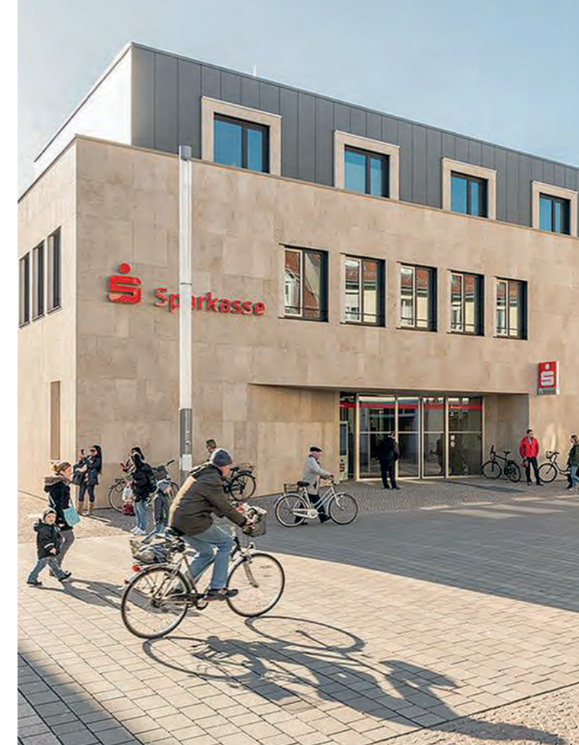
Der 2015 eröffnete Neubau der Sparkassenfiliale in Schwetzingen ist komplett im Passivhausstandard und hat ein aktives Energiemanagementsystem in der Gebäudetechnik.
